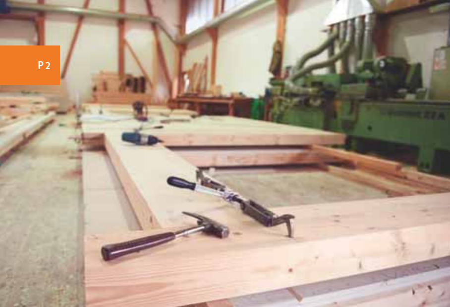
▲ Die Wände sind aus Brettsperrholz, ein Holzrahmenbau ist vorgesezt
