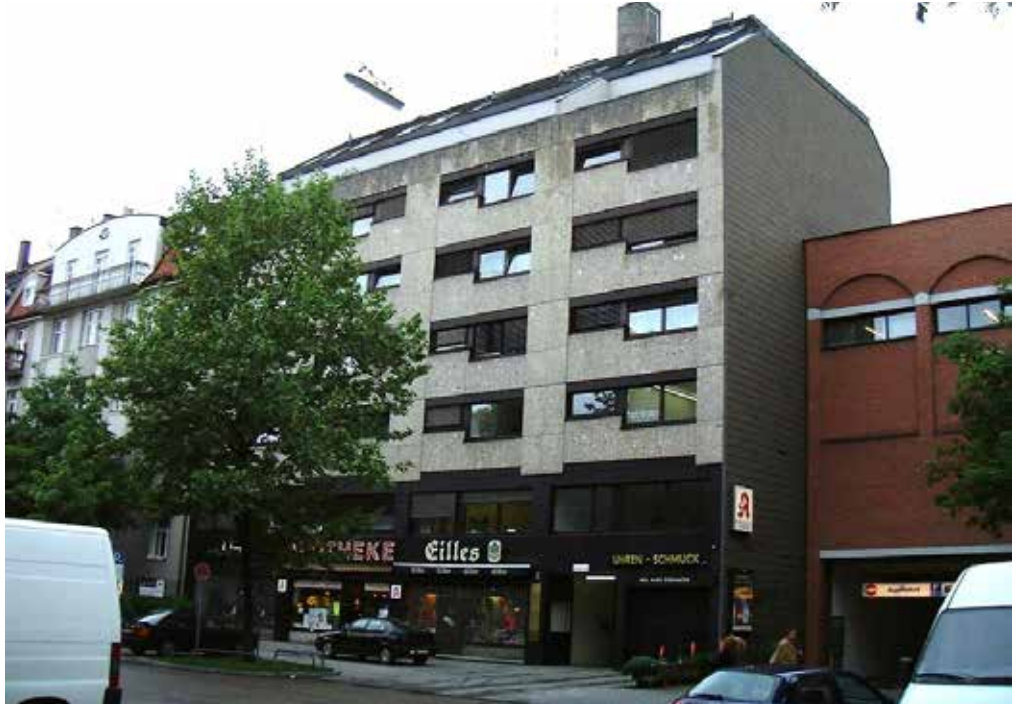
In die Jahre gekommen: So sah das Gebäude Baujahr 1972 vor der Sanierung aus.
