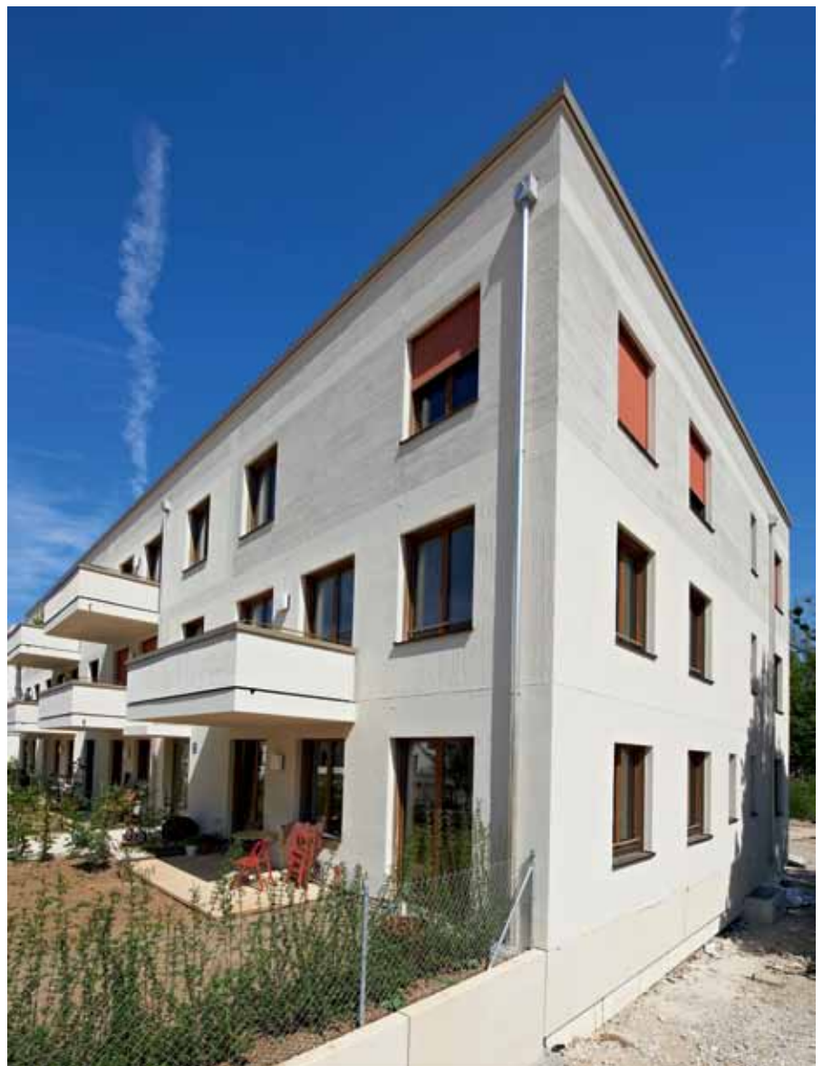
Der städtische Gestaltungsleitfaden verlangte geputzte Fassaden. Dabei setzten die Planer auf ein eher selten verwendetes, aber durchaus bewährtes Wärmedämm-Verbundsystem.
