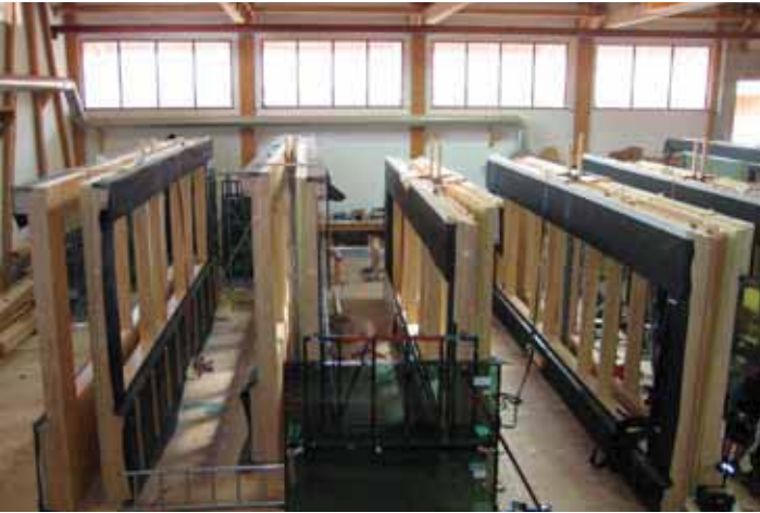
Die Fassadenelemente wurden bei der Ambros GmbH in Hopferau im Allgäu vorgefertigt
