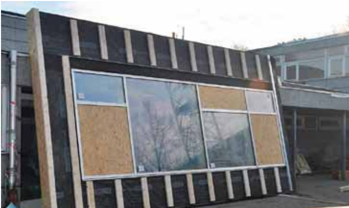
Die „TES Energyfacade“ wurde mit integrierter Wärmedämmung und Dreifach-Glasfenstern „just in time“ gelieert
