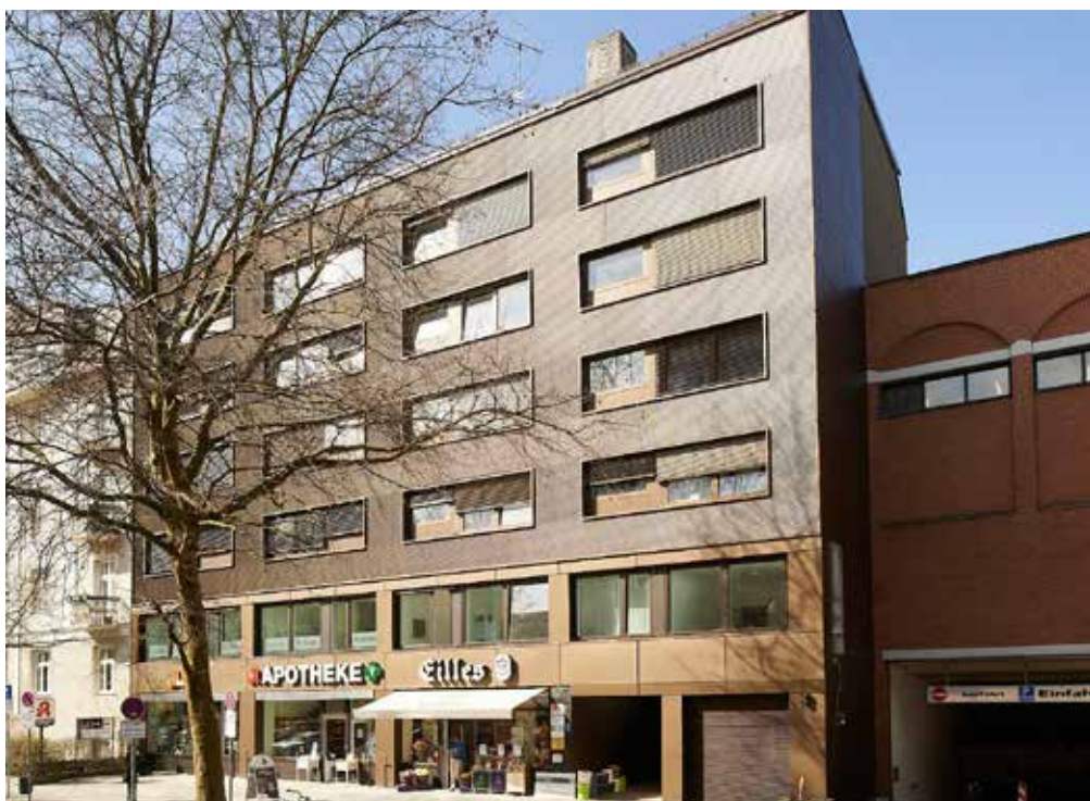
Architekten: Braun Kröttsch Architekten, Holzbau: Anton Ambros GmbH.
