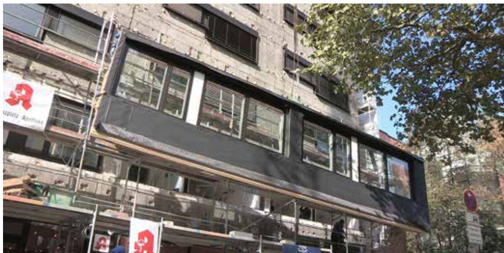
Inklusive Fenster und Dämmung wurden die circa drei mal 13 Meter großen Elemente auf die Baustelle geliefert.
