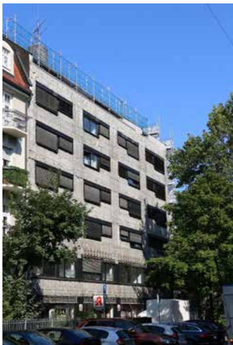
Zunächst musste die baufällige Natursteinfassade entfernt werden. Fotos: Matthias Renert
