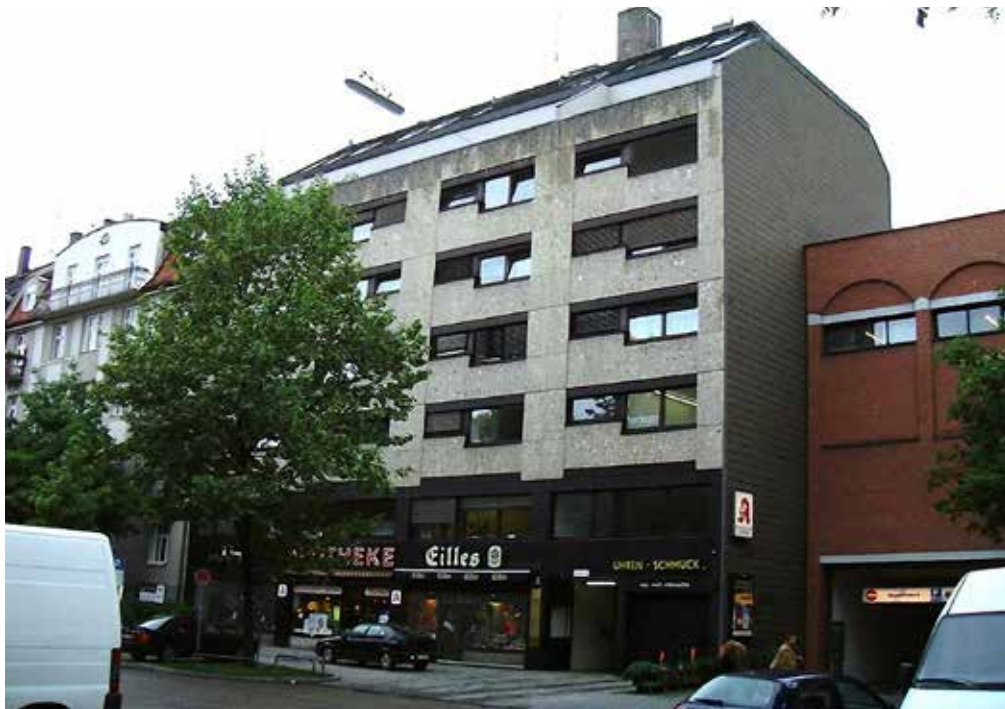
In die Jahre gekommen: So sah das Gebäude Baujahr 1972 vor der Sanierung aus.
