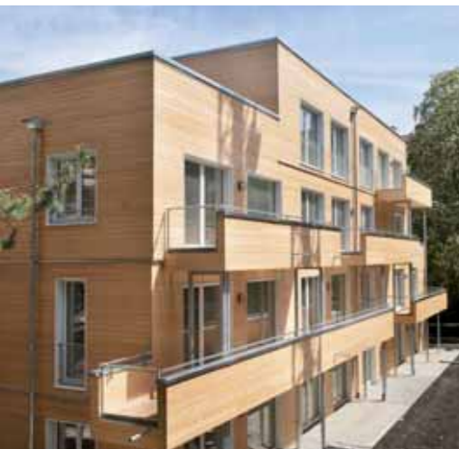
Schwabing: Der Heizwärmebedarf des Neubaus liegt bei 15 kWh/m 2 im Jahr, das entspricht ungefähr 1,5 Litern Heizöl/m 2 im Jahr.
