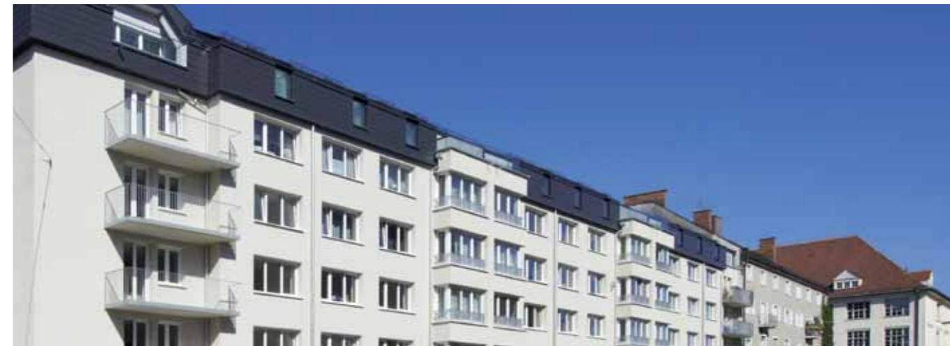
Schwabing: Der Wohnungsbestand liegt entlang der Rheinstraße sowie der Mainzer Straße und stammt aus den 1960er Jahren. Alle Fotos: © GBW, München
