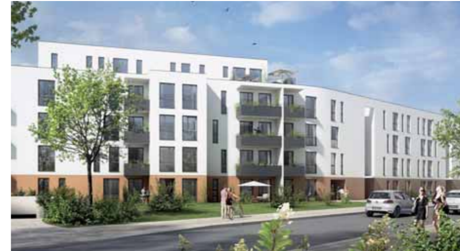
Fürstenfeldbruck: Alle Wohnungen und Freiflächen sind schwellenlos und barrierefrei ausgebildet. Der Neubau wurde als KfW-Energieeffizienzhaus 70 gemäß EnEV 2009 errichtet.
