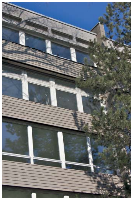
Dank des Einsatzes der TES-Fassadenelemente blieb die Struktur des Gebäudes auch nach der Sanierung erhalten
