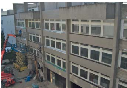
Fassade vor der Sanierung
