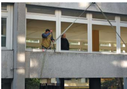
Demontage der alten Fassade
