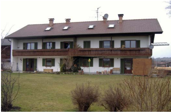
6-Familien-Wohnhaus in Hopferau vor der Sanierung (oben links) und nach der Sanierung (oben rechts)
