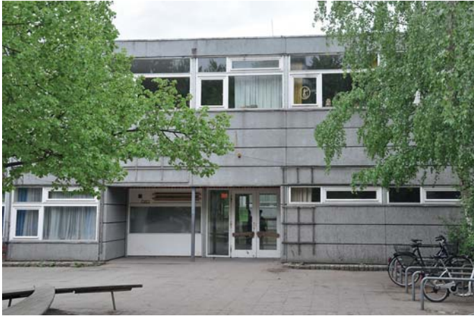
Freie Waldorfschule Märkisches Viertel in Berlin vor der Sanierung (links oben) und nach der Sanierung (links Mitte und unten)
