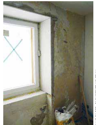
▲ Luftdichter Anschluss an die Fensterleibung mit zweilagigen Gipskartonplatten
