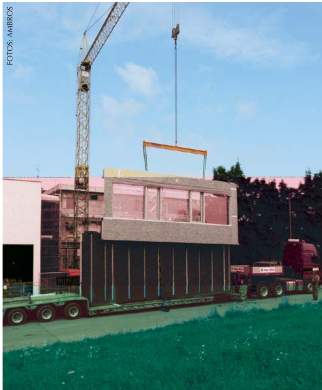
Und wieder rollt ein Stück neue Fassade für die Buchloer Realschule an. Die Elemente wurden im Ambros-Werk in Hopferau vorgefertigt.
