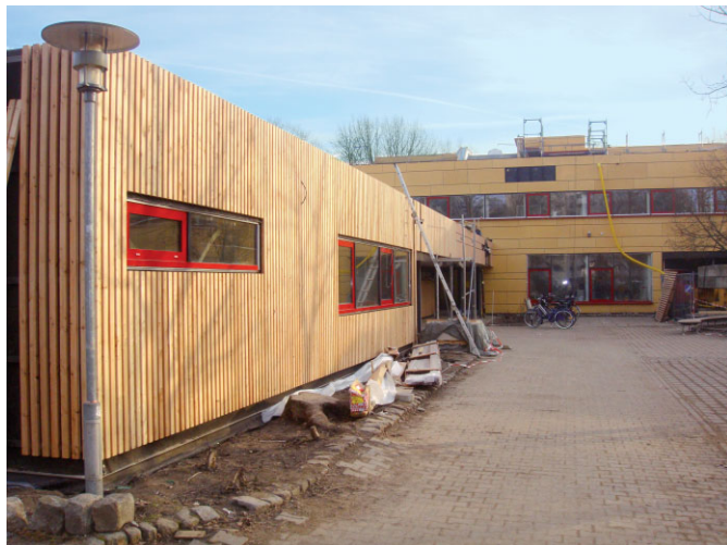
Bild 2. Energetische Sanierung der Fassade der Waldorfschule Märkisches Viertel
