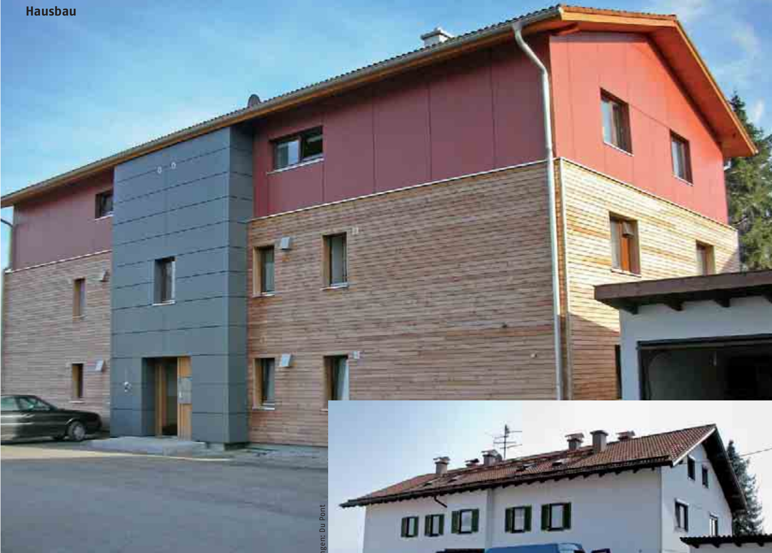
Vorher - nachher: Die energetische Sanierung machte aus einem schlichten Mehrfamilienhaus ein modernes Gebäude.
