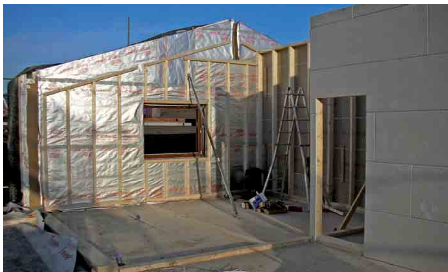
Die Giebelwand des aufgestockten Dachgeschosses zeigt die an der Oberfläche metallisierte Dampfsperre, die die Wärme im Winter nach innen reflektieren soll.
