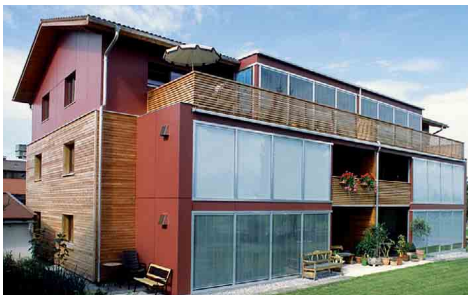
Ambros ersetzte die alten Balkone durch Wintergärten.
