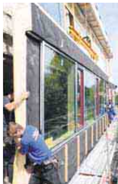
Die Mitarbeiter der Spezialfirma montieren die riesigen Elemente an der Fassade der Realschule.
