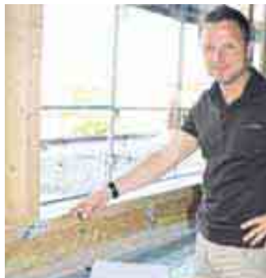
Planer Alexander Müller aus Marktoberdorf erklärt, wie die Fassadenelemente befestigt werden.
