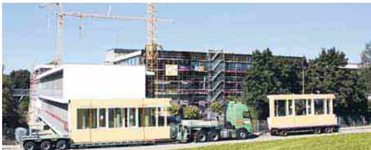
Mit schweren Sattelschleppern werden die bis zu zehn Meter breiten und dreieinhalb Meter hohen Fassadenelemente angeliefert. Links im Bild der moderne Anbau der Staatlichen Realschule, rechts der Haupttrakt, der derzeit für insgesamt knapp fünf Millionen Euro generalsaniert wird.
