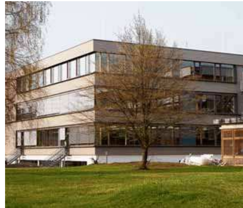
Unter anderem an der Realschule in Buchloe wurde das von der Firma Anton Ambros GmbH aus Hopferau entwickelte und zweifach ausgezeichnete TES-Fassadensystem verbaut. Foto: Frank Lattke
