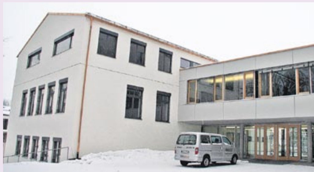
Die Fassadengestaltung wurde an das Design des alten Schulgebäudes angepasst.
