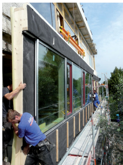
Der Gebäudesanierung mit vorgefertigten Fassadenelementen gehört die Zukunft (Foto: Ambros)
