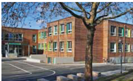
Kaum wiederzuerkennen – die Grundschule in der Albert-Schweitzer-Straße in Ottobrunn wurde rundum erneuert Fotos: S. Katzer/Architektur Fischer + Steiger, München
