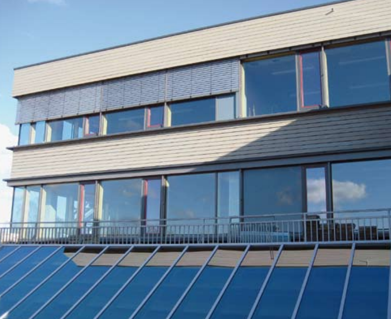
▲ Rund 2000 m 2 Fassadenfläche tauschten die Holzbauer nach einer ...
