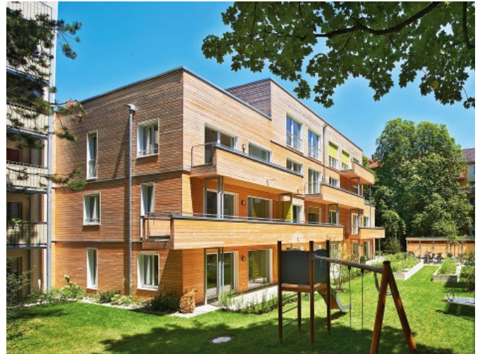
Bild 1. Nachverdichtung eines Innenhofs in der Mainzer Straße in München-Schwabing, Auftraggeber: GBW AG, Holzbau: Anton Ambros GmbH
